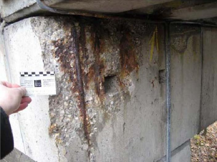
Pfeilerreihe West, Kopfbalken, Betonausbruchstelle und korrodierte Eisen
