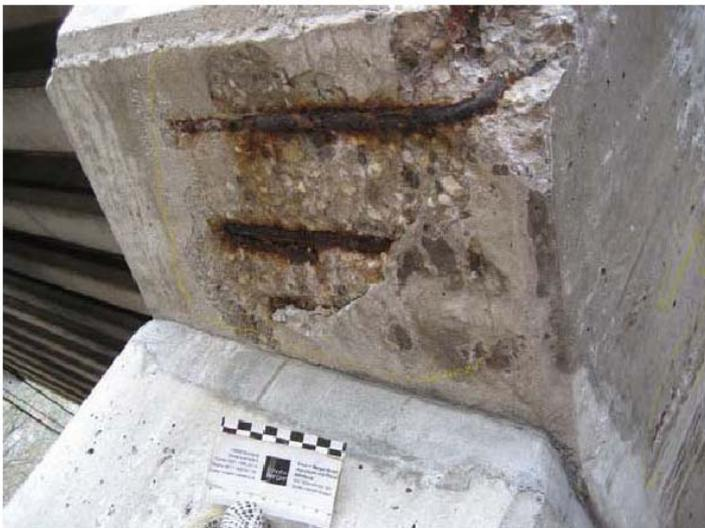
Pfeilerreihe West, Kopfbalken, Betonausbruchstelle und korrodierte Eisen
