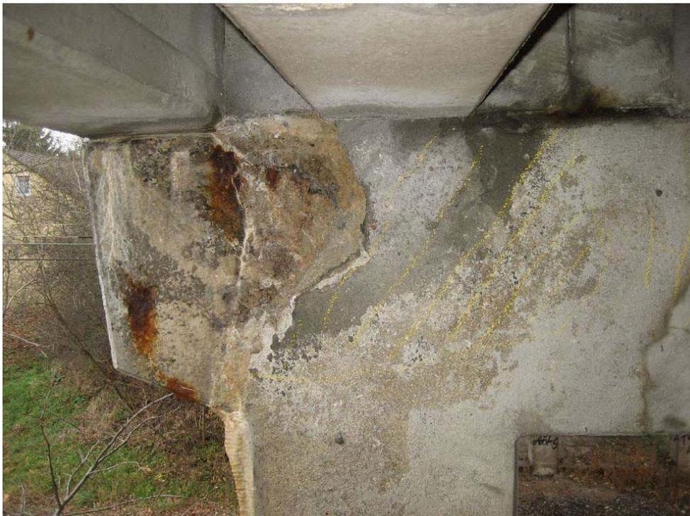
Pfeilerreihe Ost, Kopfbalken, Betonausbruchstelle, Hohlstelle, korrodierte Eisen, etc.
