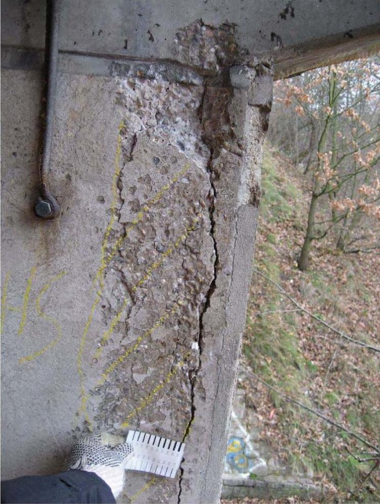
Pfeilerreihe Ost, Pfeiler Süd, Hohlstelle, Betonausbruchstelle und 3mm Riss.
