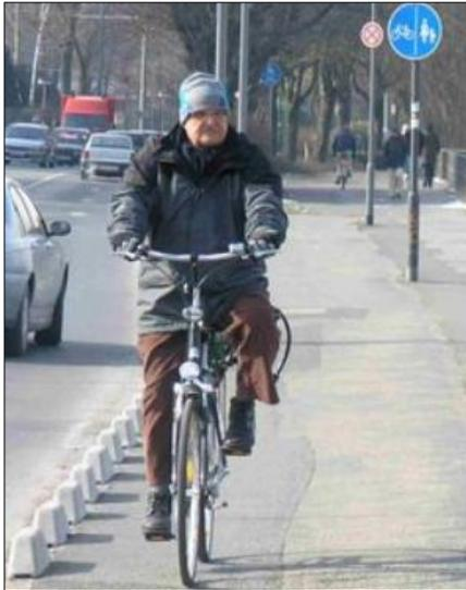
Die Überwachung durch den Vollzugsdienst brachte in der Vergangenheit keinerlei Besserung. Deshalb wurde überlegt, den Radstreifen mittels eines sog. „Frankfurter Huts“ (vgl. Abb. links) freizuhalten. Dieser wird auf der Fläche der Markierung montiert, benötigt aber einen entsprechenden Unterbau. Er kann vom MIV nicht überfahren werden und engt den Straßenraum bei Feuerwehreinsätzen nicht ein. Seitens SVA wird eine bauliche Trennung des Radstreifens gefordert.
