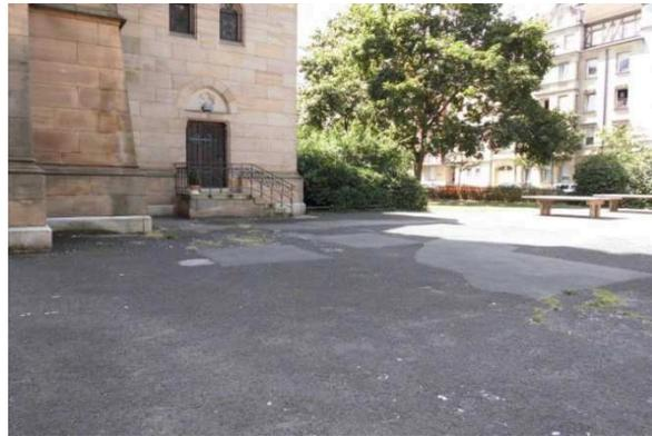
Der Belag der anschließenden Plattenwege und -flächen ist vielfach gebrochen. Aufragende Plattenkanten und Unebenheiten durch Setzungen des Unterbaus stellen gefährliche Stolperfallen dar.
