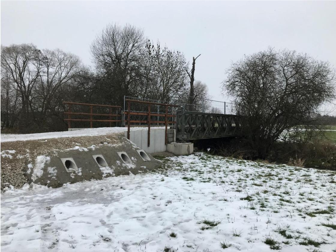
Bild 2: Ansicht Behelfsbauwerk mit Anrampung des Feldweges
