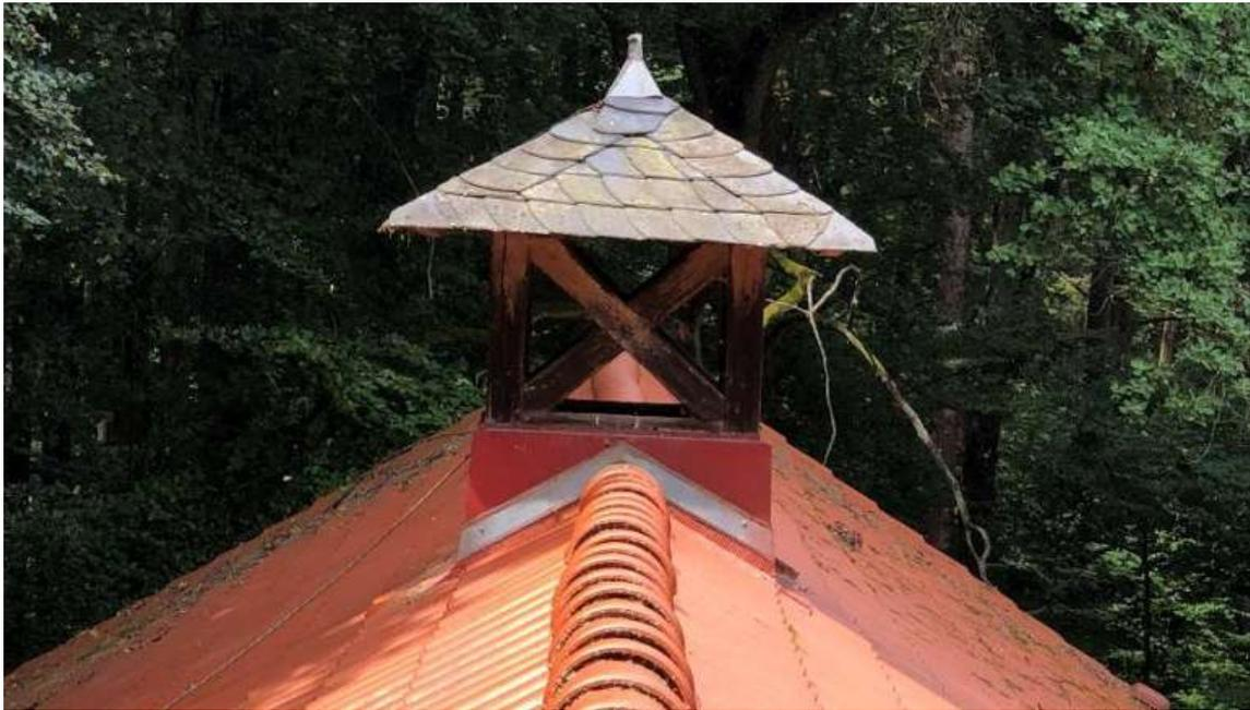
Abbildung 4: Dach mit Dachreiter (Lüftungsturm)
