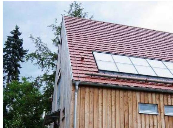
POSITIVBEISPIEL: IN DIE DACHFLÄCHE INTEGRIERTE PHOTOVOLTAIKMODULE
