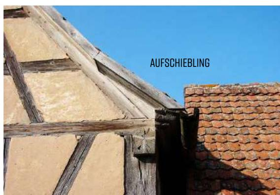
Auch am **Ortgang**, dem seitlichen Abschluss des Daches zur Wand, ist kein Überstand üblich. Es gibt hier vielfältige Formen des Abschlusses: die üblichste ist eine Zahnleiste, in die die Ziegel eingebettet sind und unterseitig eine Deckleiste, die an der Dachlattung befestigt ist.
