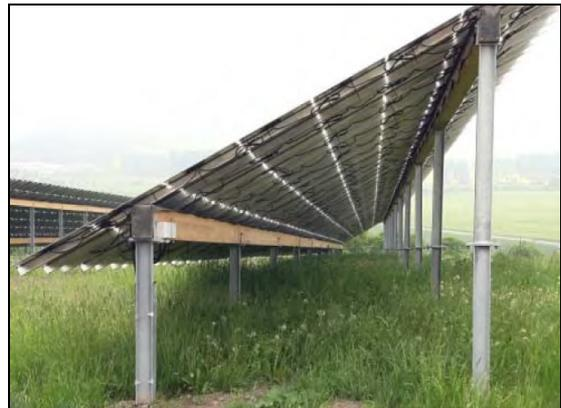
Um in unseren Breiten im Jahresgang einen optimalen Energieertrag zu erzielen, werden die Modultische mit einem konstanten Neigungswinkel gegenüber der Horizontalen von etwa 30° in Südrichtung (Azimutwinkel 0°) aufgestellt. Gemäß dem anerkannten Stand der Technik sollen nur Photovoltaik-Module mit entsprechender Zertifizierung zum Einsatz kommen. Im Ergebnis der Umweltprüfung werden zur Vermeidung negativer Wirkungen reflexionsarme Photovoltaik-Module eingesetzt.
