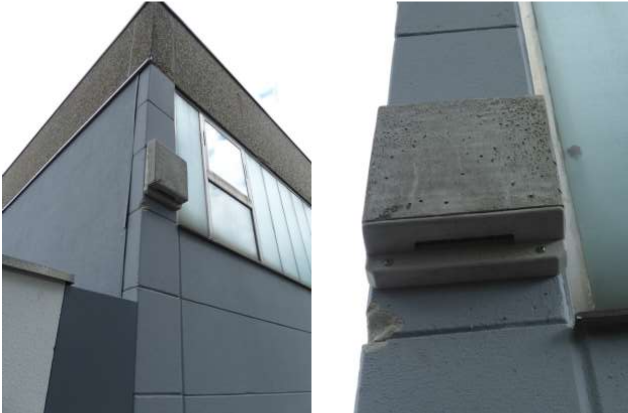
Abbildung 5: 1 Flachkasten-Montage an der Gebäude-Ecke West, auf Betonplatten, südexponiert Für Fledermäuse, die Spaltenquartiere an Gebäuden bewohnen
