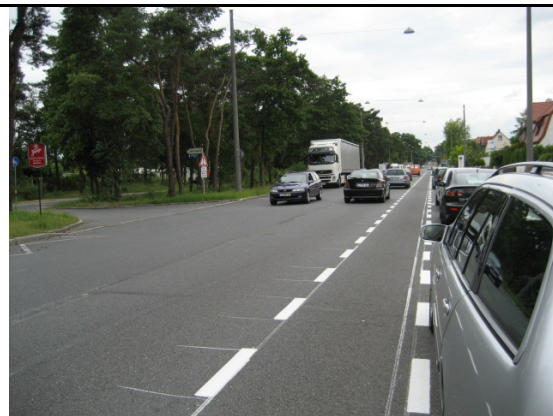
Schutzstreifen in der Erlanger Straße
