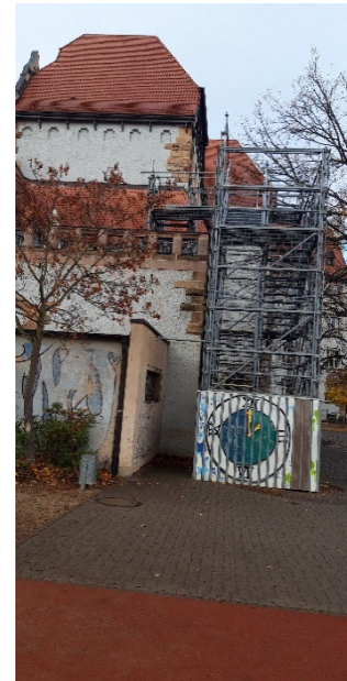
Pestalozzistr. 20 stadteigener Gerüstturm
