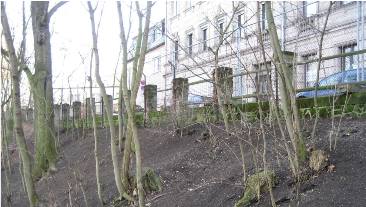
Ansicht Böschung mit Stützwand und Zaun – Blick vom Fußweg Stadtpark zur Engelhardtstraße
