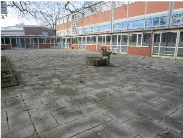
Blick in den Hof mit Brunnenanlage
