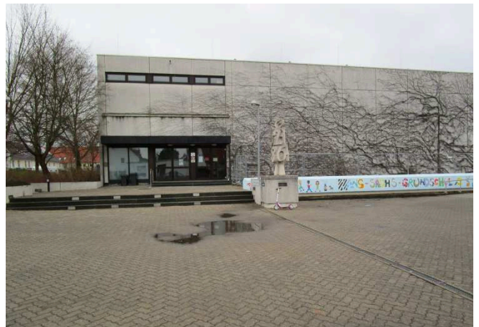
Nicht funktionierende Entwässerung
