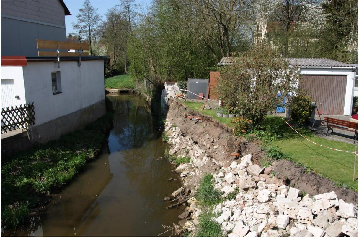
nach der Räumung der Mauerreste aus dem Gewässer und prov. Ufersicherung am 26.08.2017
