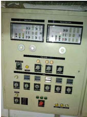
Abbildung 128: Schule Ligusterweg, Regelung Heizung und Lüftung
