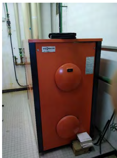
Abbildung 127: Schule Ligusterweg, Warmwasserbereithaltung
