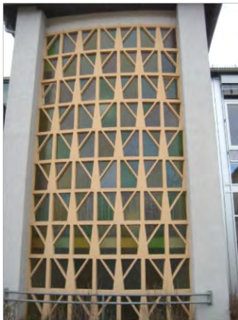
Abbildung 110: Mittelschule Kiderlinstraße, Ansicht Lüftungsfenster
