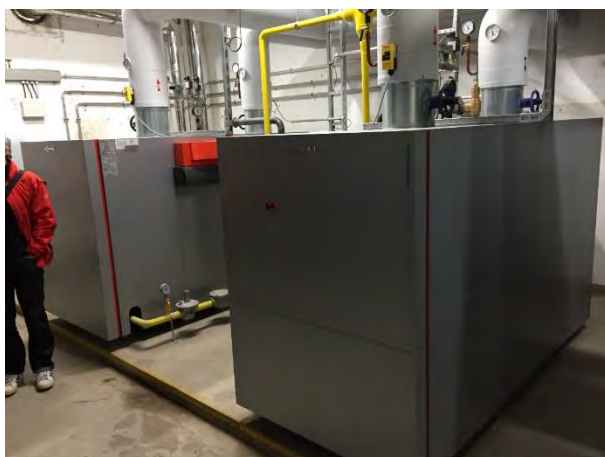
Abbildung 104: Mittelschule Soldnerstraße, Steuerung
