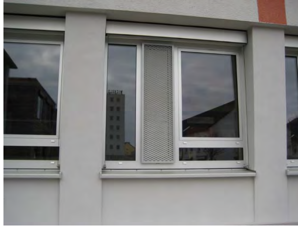
Abbildung 110: Mittelschule Kiderlinstraße, Ansicht Lüftungsfenster
