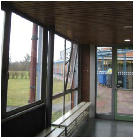
Abbildung 102: Mittelschule Soldnerstraße, Flur EG saniert
