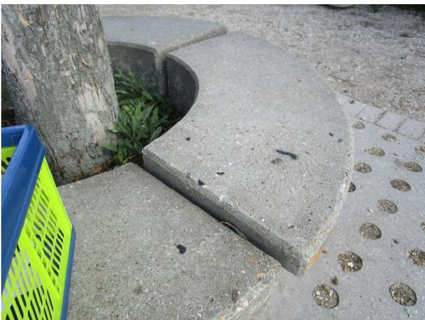
verschobene Einfassung durch Wurzelndruck
