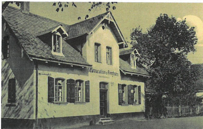
Restauration zur Ringbahn, Aufnahme um 1900
