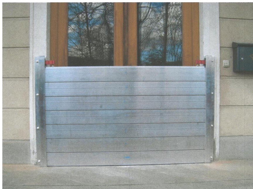
Abb. 7: Beispieldarstellung Dammbalkenverschluss in Türrahmen
