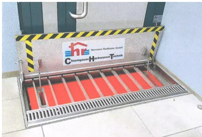
Abb. 8: Musterbeispiel fest eingebautes klappbares Staulement
