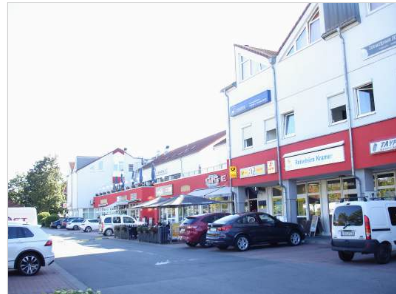
Blick von der Stellplatzanlage auf Ladenzeile in südlicher Richtung
