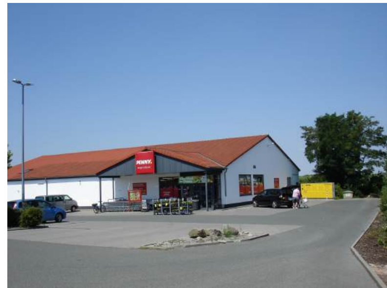
Blick auf Eingangsbereich des Penny-Lebensmitteldiscounters in nördlicher Richtung
