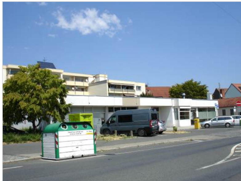
Blick auf Projektstandort (ehem. Norma u. Bäckerei) in östlicher Richtung
