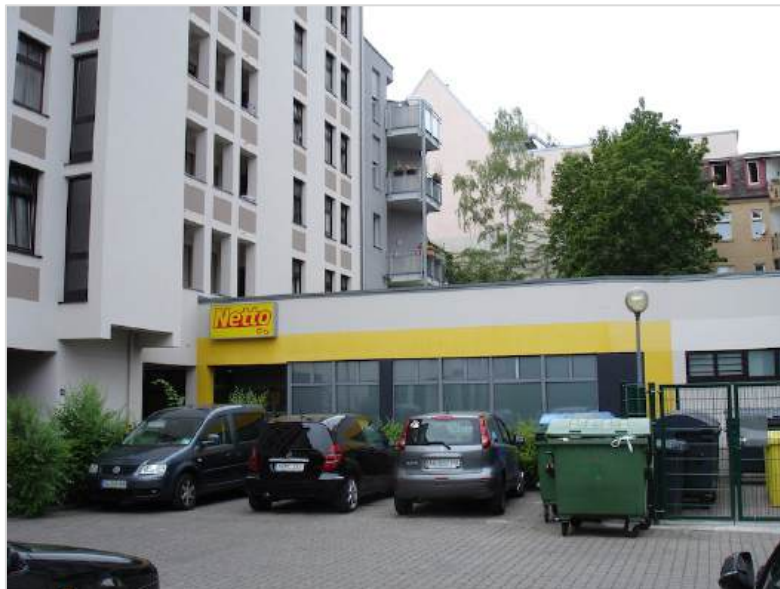
Blick auf Eingangsbereich des Netto City-Marktes in nordwestlicher Richtung
