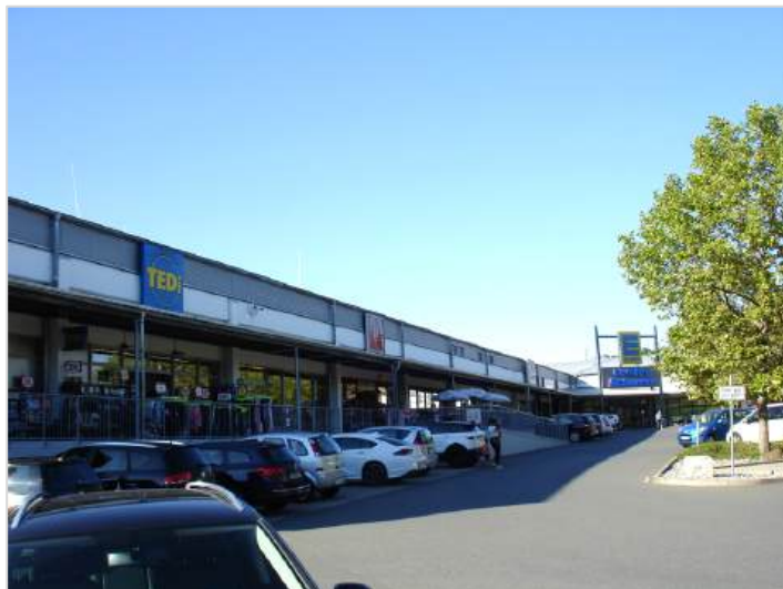
Blick auf Stellplatzanlage, Fachmarktriegel und Eingang E-Center Scharrer in nördlicher Richtung
