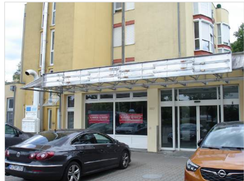
Blick auf Eingangsbereich des früheren nah&gut-Supermarktes
