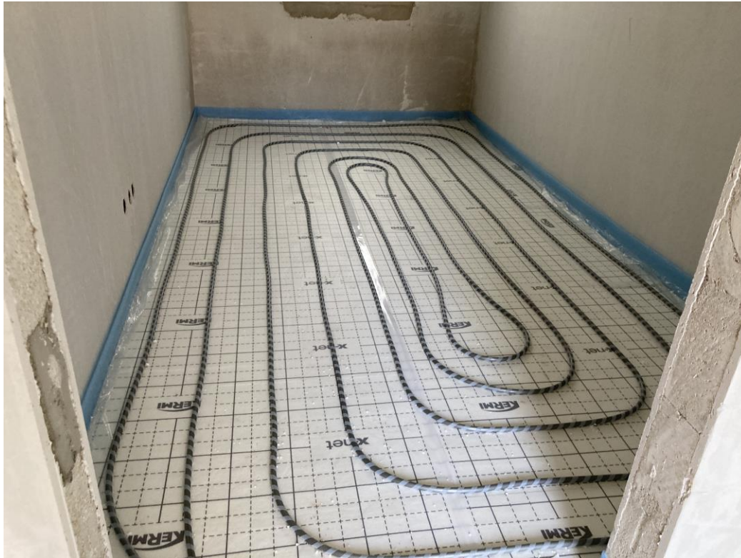
Die Fußbodenheizung ist gesamtheitlich eingebracht.
