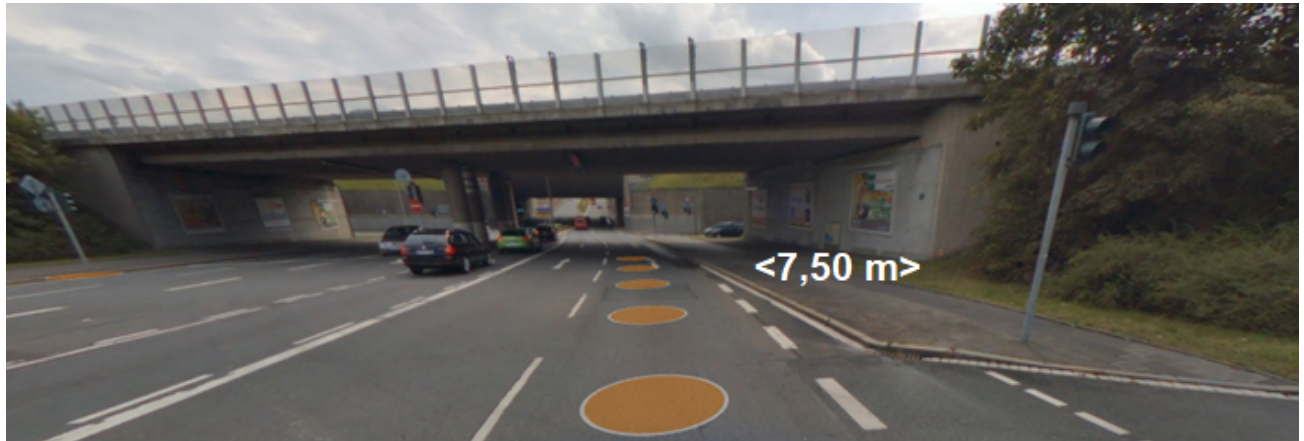
Abbildung 1: Schwabacher Brücke im Bestand, Foto 2014
