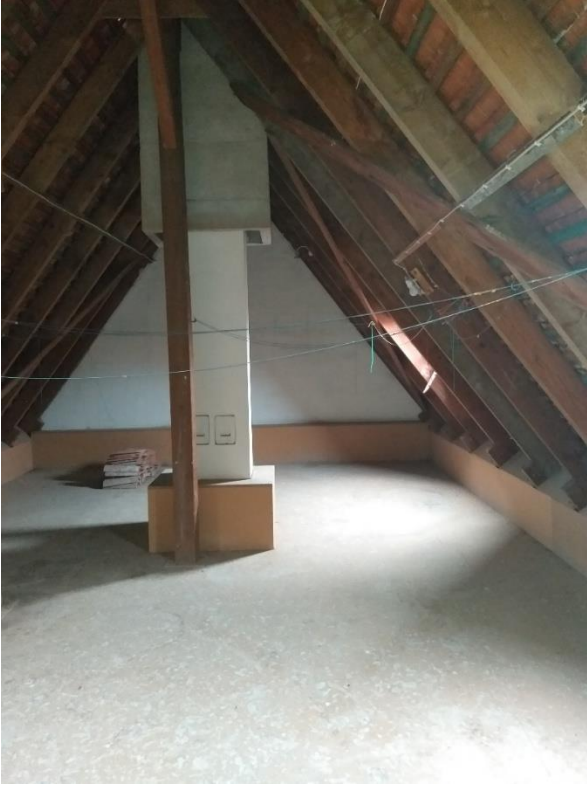
Bild 1: Dachboden vor dem Umbau
