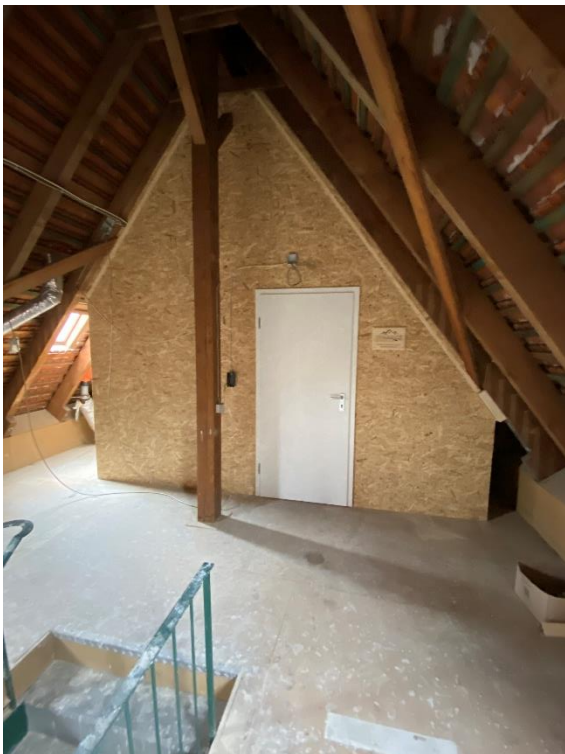
Bild 2: Vom Dachboden abgetrennter Taubenschlag
