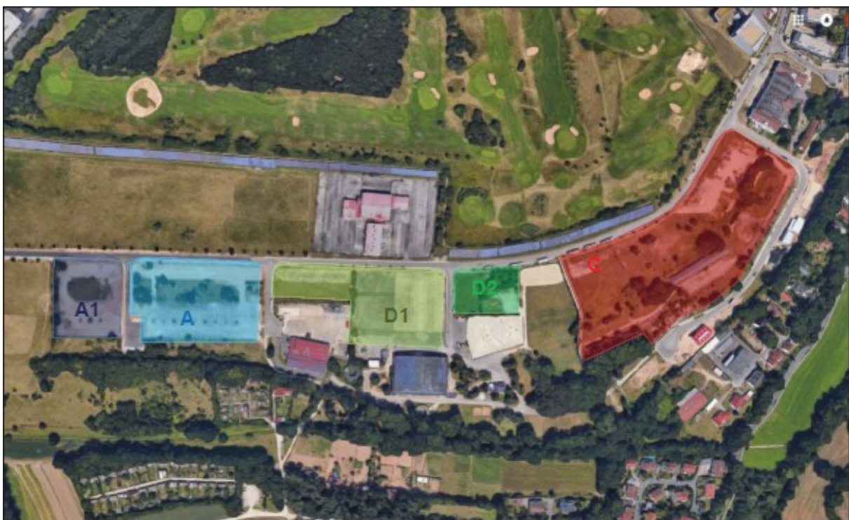
Abbildung 3: Übersicht über die rückgebauten Teilflächen A, C und D, Quelle: Endbericht Rückbau Flächen A, C, und D, 11.09.2020, Gutachter Gibs Ing.
