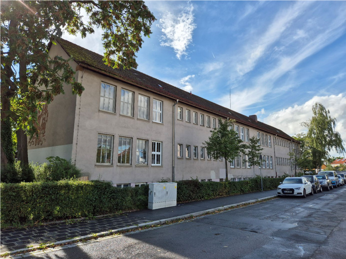
Seitenansicht Nordfassade; I.Bauabschnitt aus 1950
