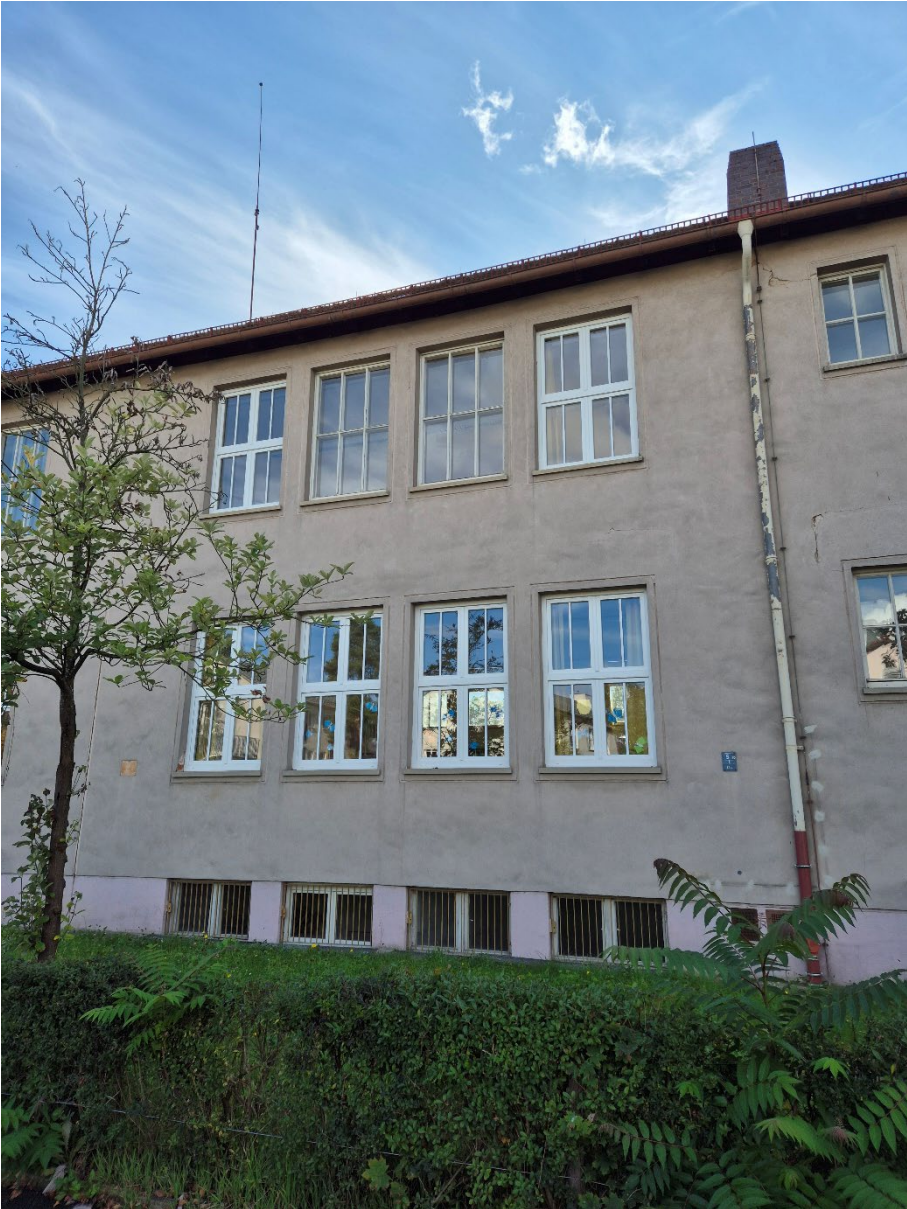
Teilansicht von außen; historische Fenster oben Mitte.
