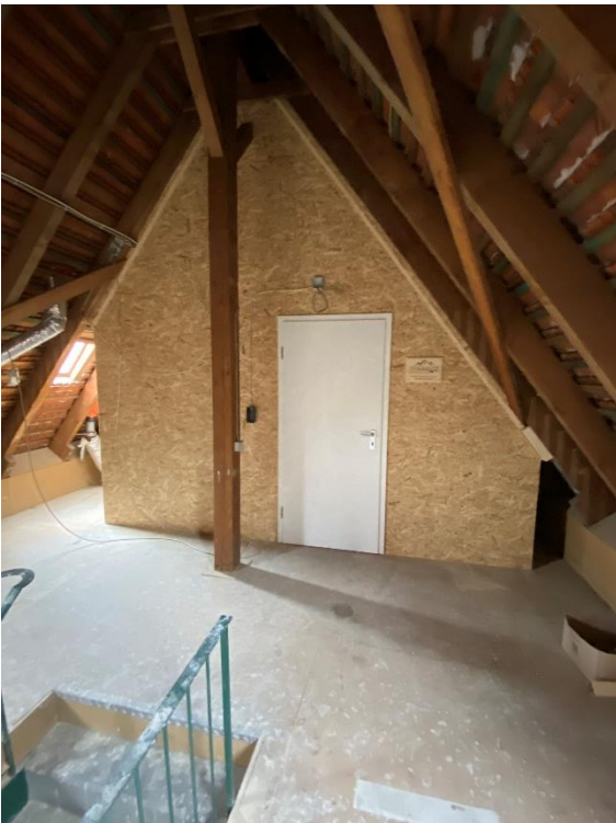
Bild 2: Vom Dachboden abgetrennter Taubenschlag
