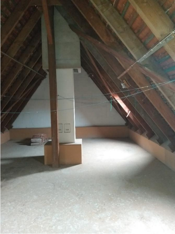
Bild 1: Dachboden vor dem Umbau
