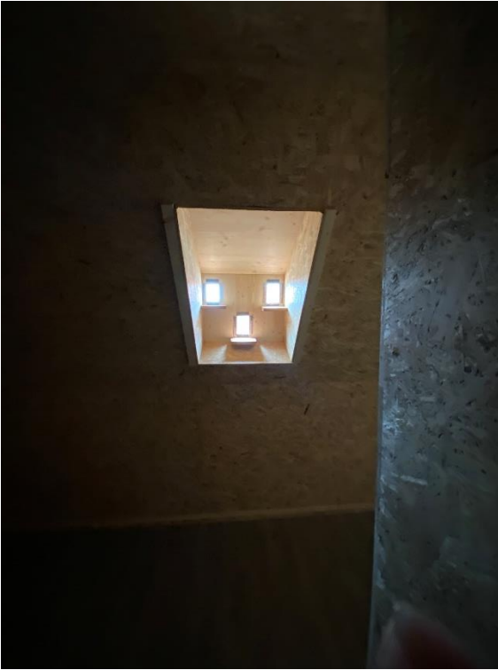
Bild 3: eingebaute Dachgaube
