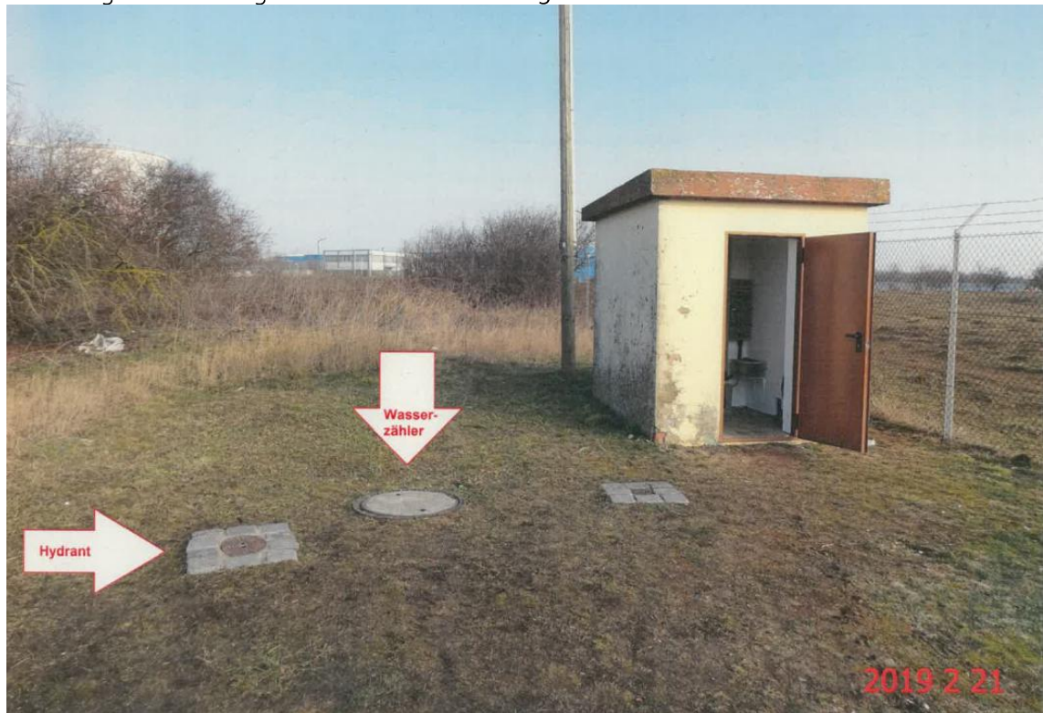
Abbildung 9: Schaltanlagenhaus PW Rosenstockweg
