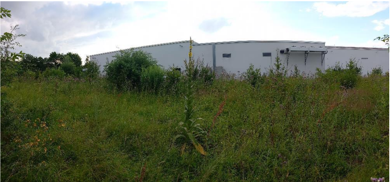
Abbildung 4: Ansicht des Bestandsgebäudes im Süden, Bereich des Vorhabens; (Foto: Bachmann Artenschutz GmbH)
