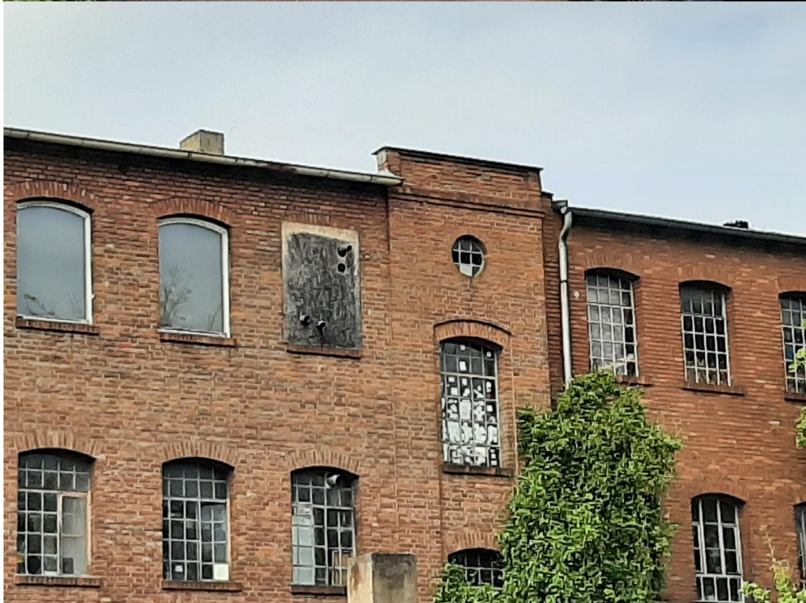
5 und 6: Ziegelsteinfassade der Abbeizerei mit Einflugöffnungen, geeignet für Fledermäuse und ggf. auch für Vögel (z.B. Dohle, Schleiereule)
