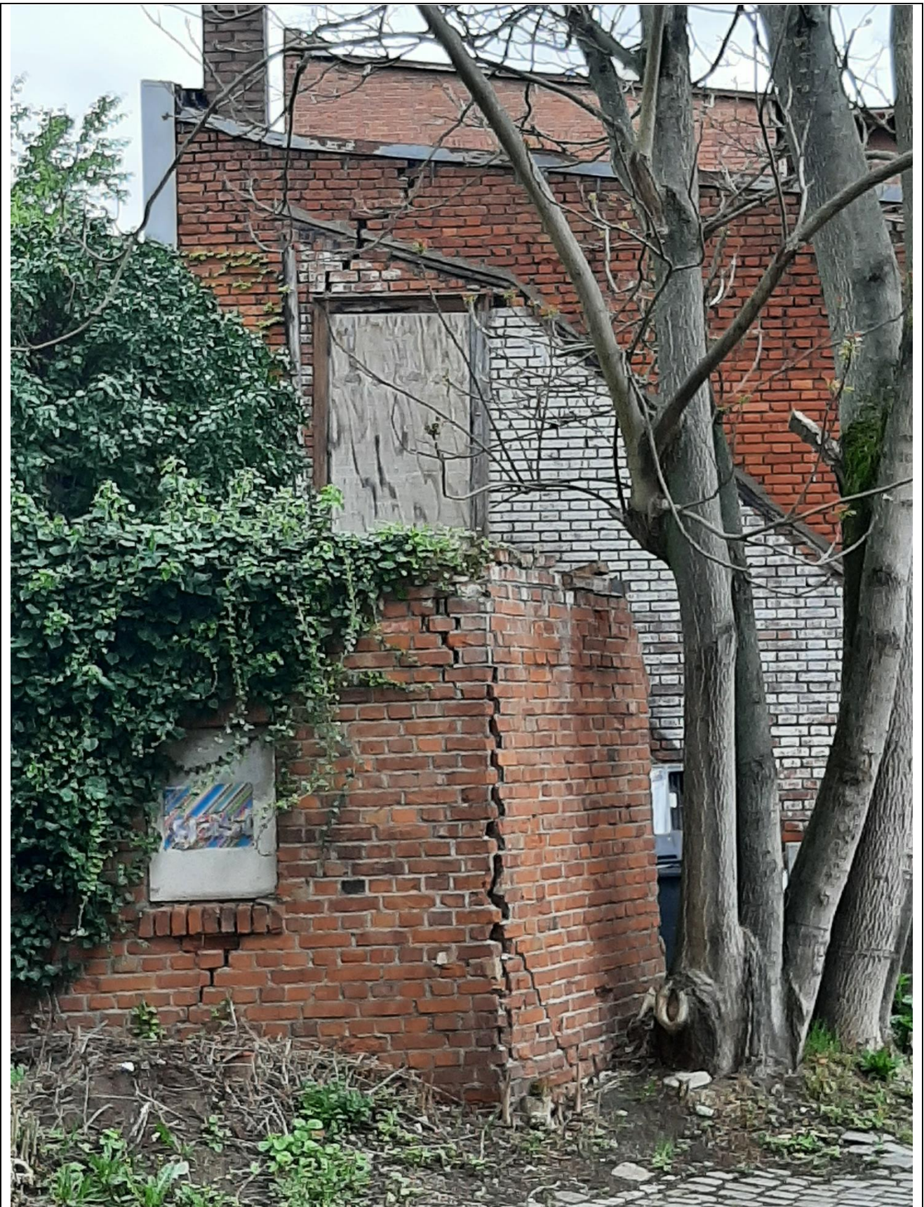
3: Ziegelmauerwerk mit Spalten, geeignet für Fledermäuse als Einflugmöglichkeiten.
