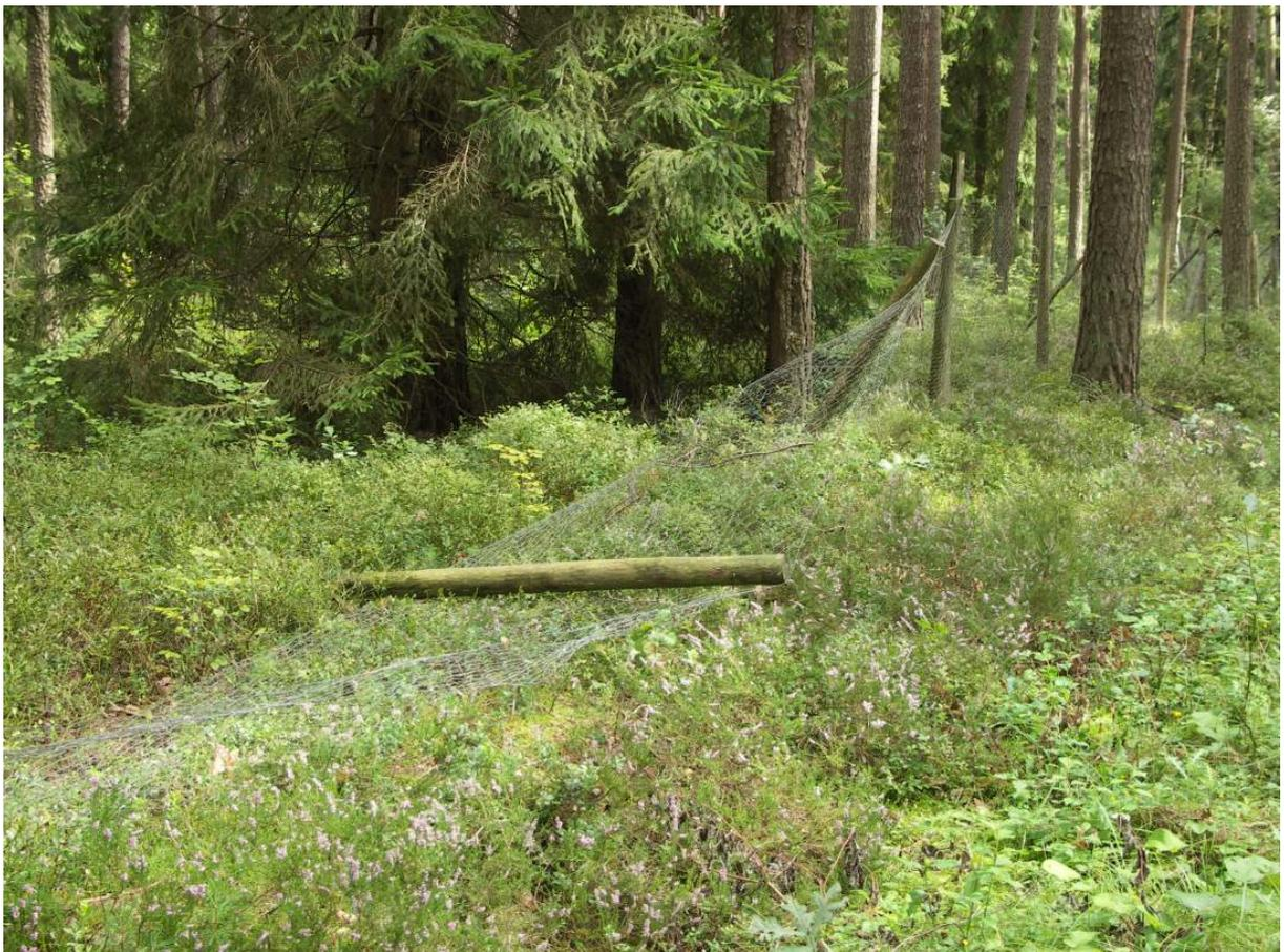
**Abbildung 1:** *Großflächiger Zaun mit zum Teil erheblichen Instandhaltungsaufwand (Bestand I. 12<sup>1</sup>)*
