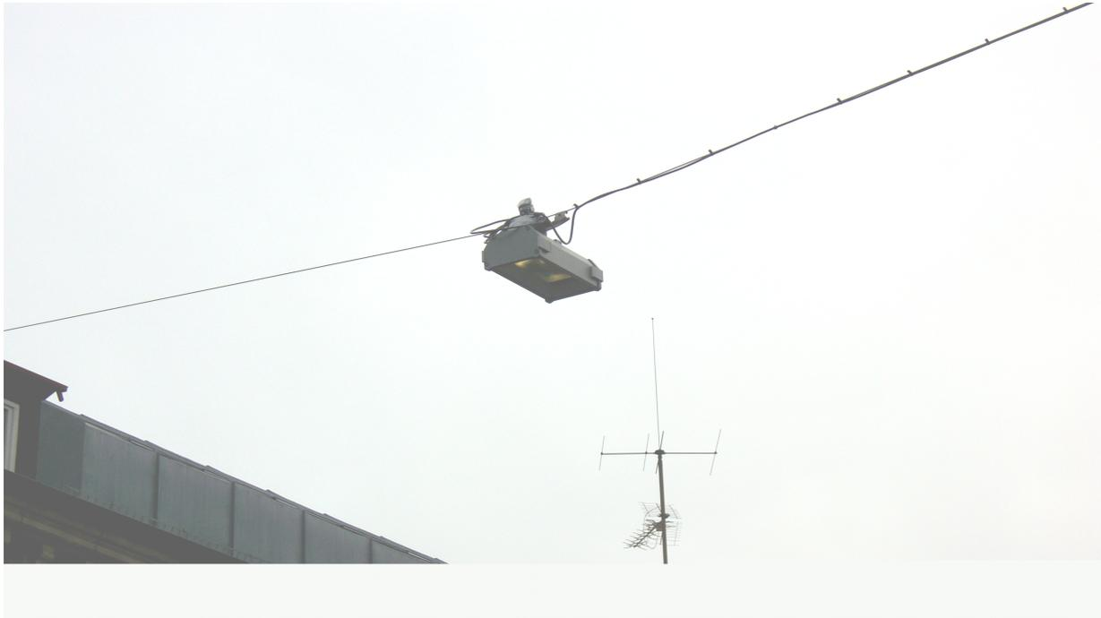
**Leuchte Typ 2** Bestückt mit 2x 54 Watt Leuchtstofflampen
