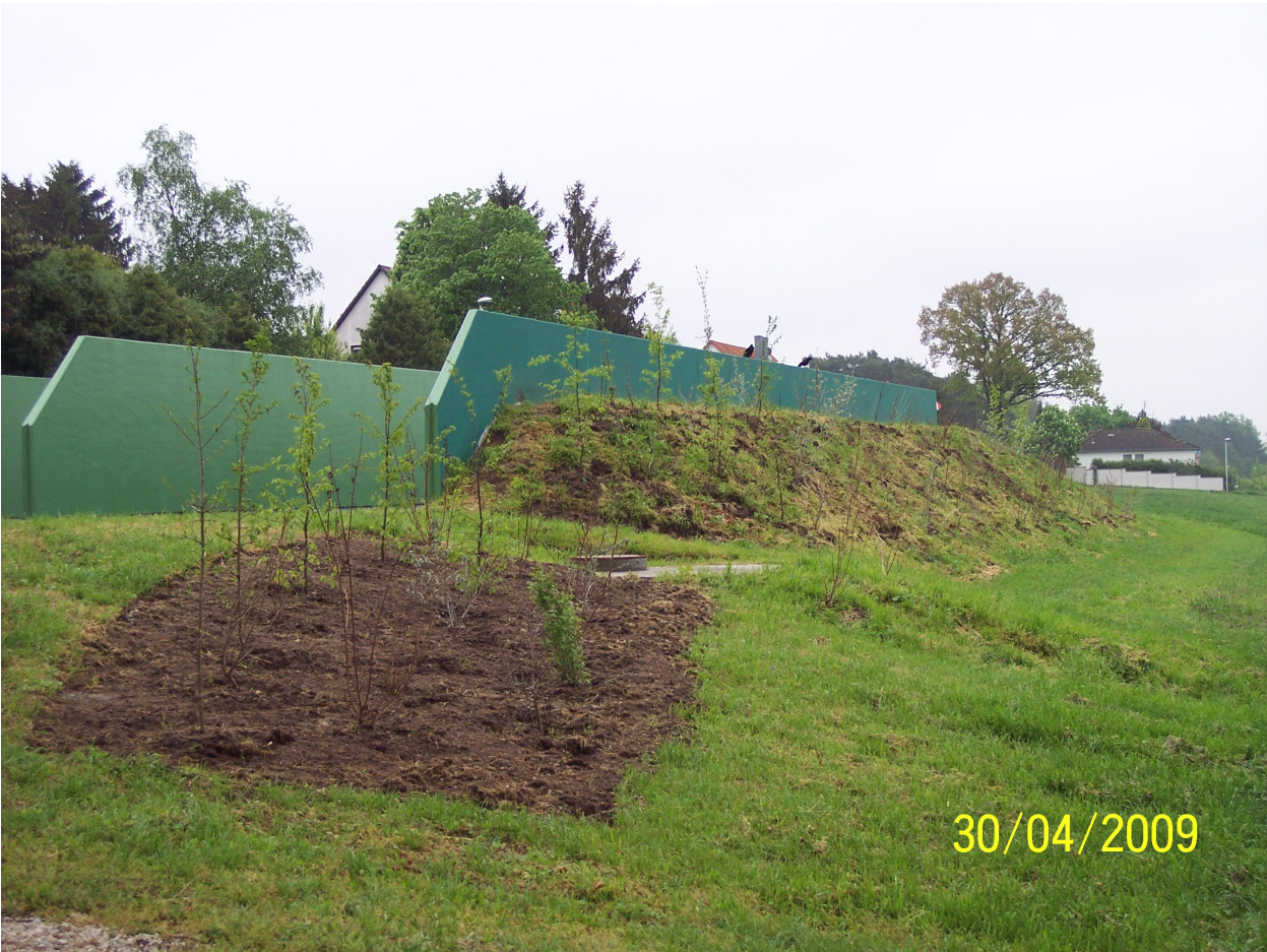
Bild 1: Dreireihige Eingrünung der Westseite in Richtung Talraum der Regnitz
